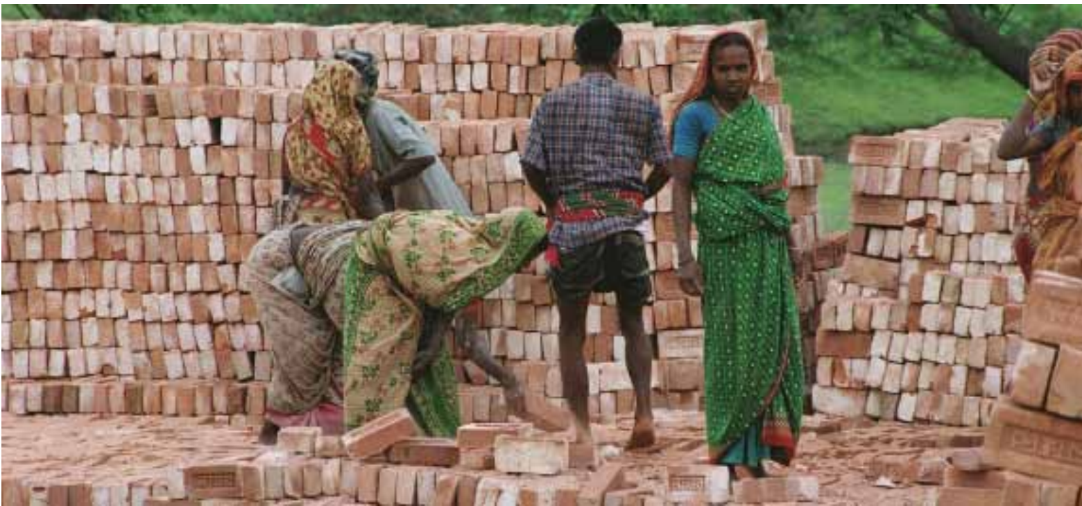
Photo: Banco Mundial/Scott Wallace Trabajadores bengalíes colocan ladrillos en Dhaka, Bangladesh.
